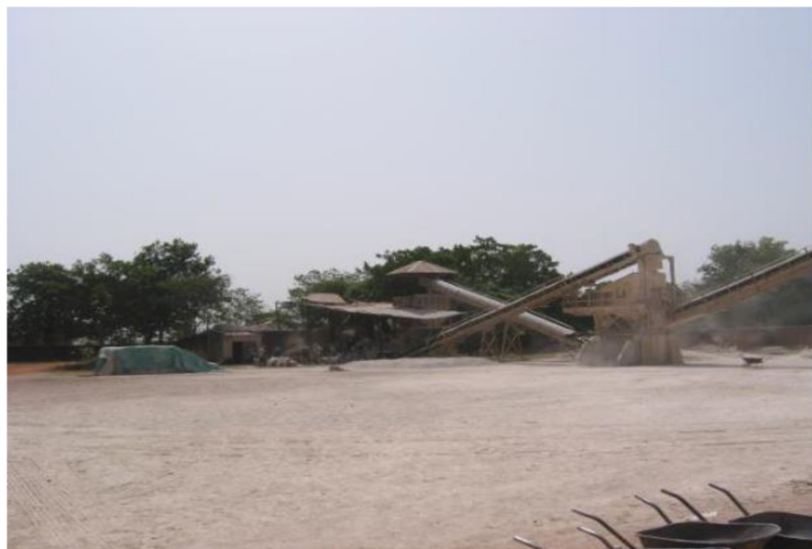
Unité de concassage / broyage de la dolomie
